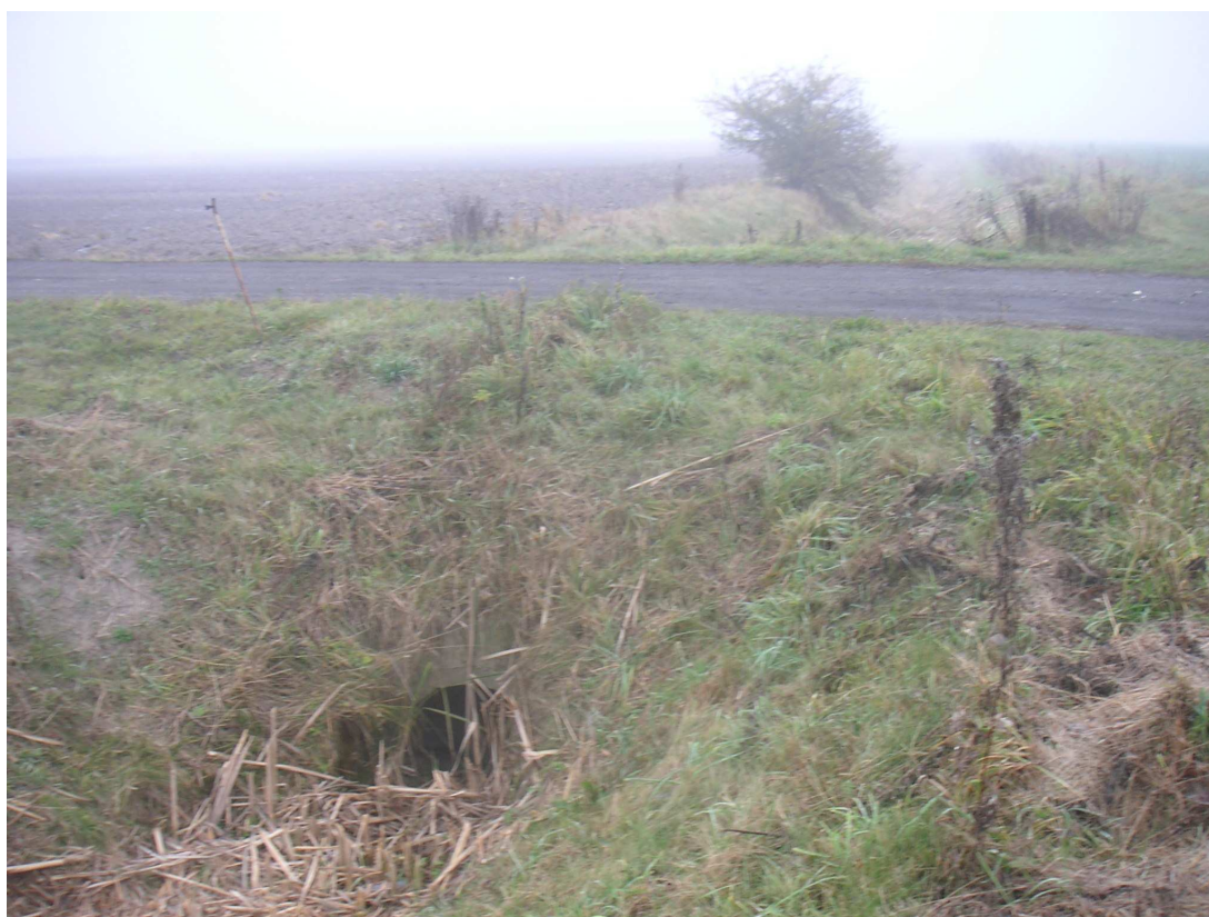
Fot. 2. Widok na przepust na rowie melioracyjnym w km 0+953
