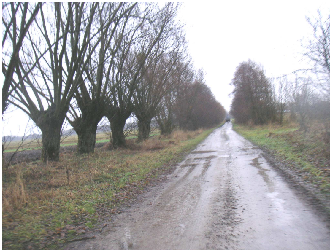
Fot. 1. Widok w km 0+250
