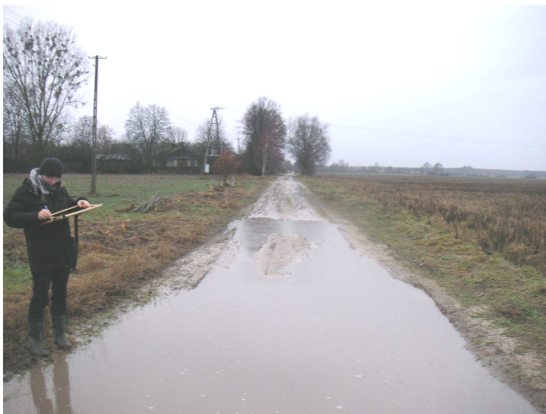
Fot. 2. Widok w km 1+180.00
