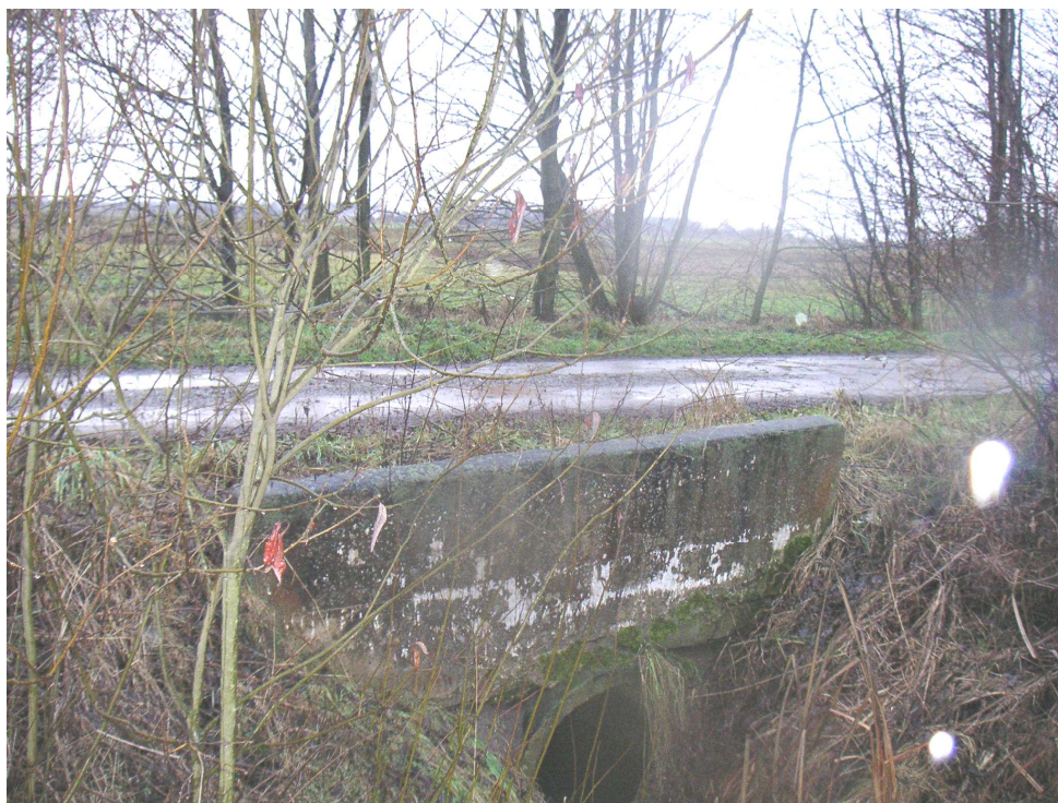
Fot. 33. Widok ścianek przepustu w km 0+452,4 przewidzianych do przebudowy
