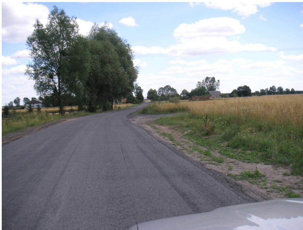
Fot. 1. Widok z drogi powiatowej nr 1084L na skrzyżowanie z drogą gminną nr 101210L
