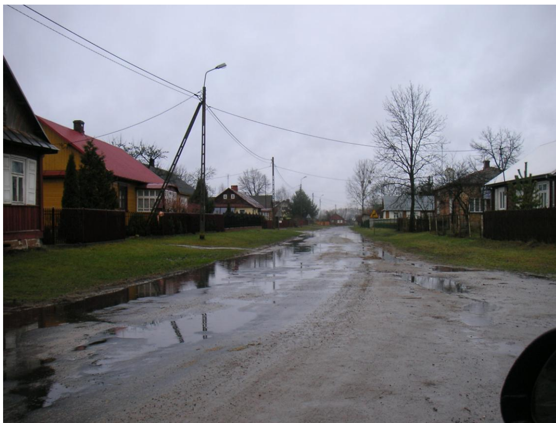
Fot 1. Widok drogi powiatowej nr 1085L w obrębie skrzyżowania z drogą gminną nr 101196L
